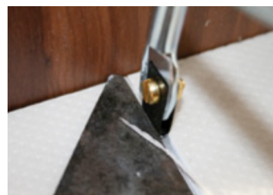
Encoche de jointure de parois
